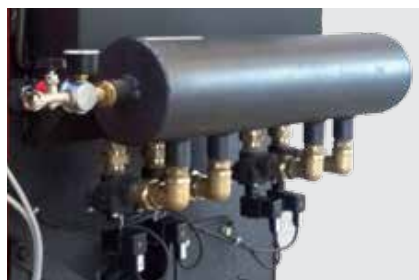
Limpieza neumática de los tubos de intercambio
